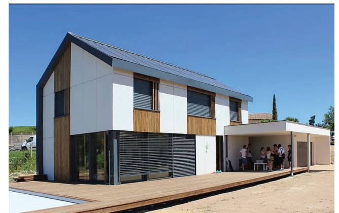
façades revêtues d'un bardage bois et de panneaux de bardage en fibro-ciment ou composite
